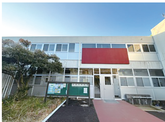
改修後の総合研究棟 (保健体育系)
