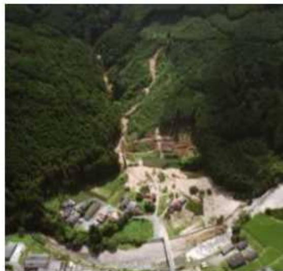
△八女市星野村の土石流発生状況
