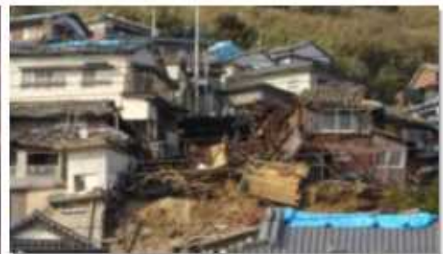
△急な斜面での表層崩壊
