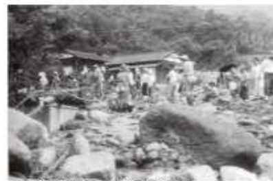
△太宰府地区土石流被害状況
