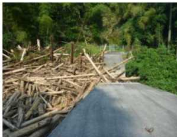
△砂防堰堤による土石流捕捉状況
