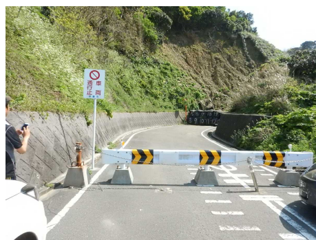
湯川山での土砂災害
