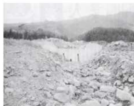
△復旧状況(砂防堰堤)
