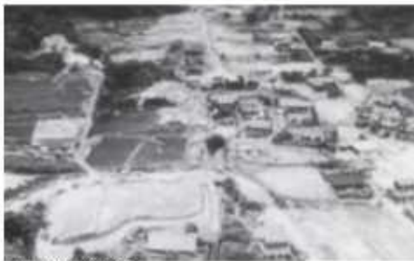
△原川被災状況
