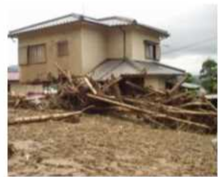
△太宰府市三条地区の土石流被害状況
