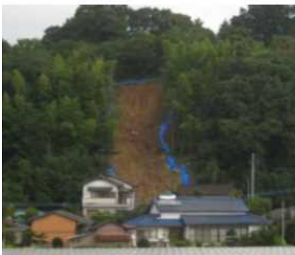
△朝倉市杷木池田のがけ崩れ状況
