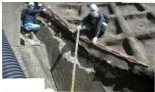
△法枠工の被災状況
