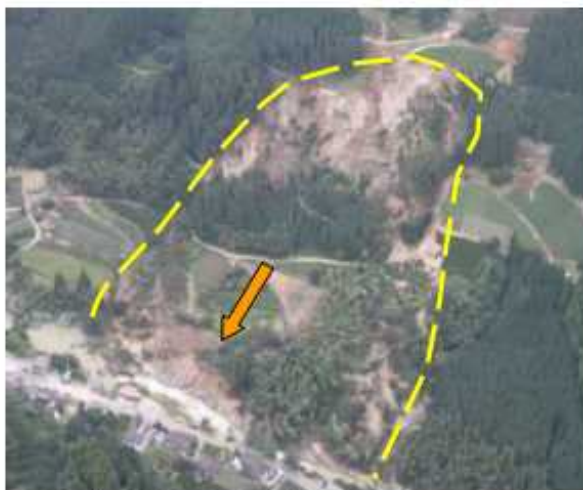
△八女市星野村の地すべり状況
