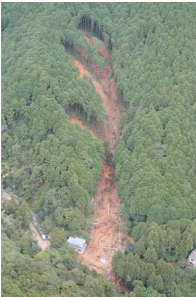
△篠栗町一の滝地区の土石流発生状況
