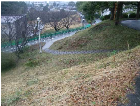
擬木で滑りやすい階段 <改修前>
