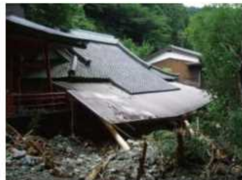
△篠栗町一の滝地区の土石流災害状況
