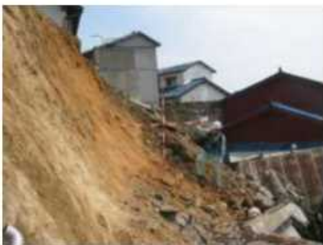
△斜面崩壊状況
